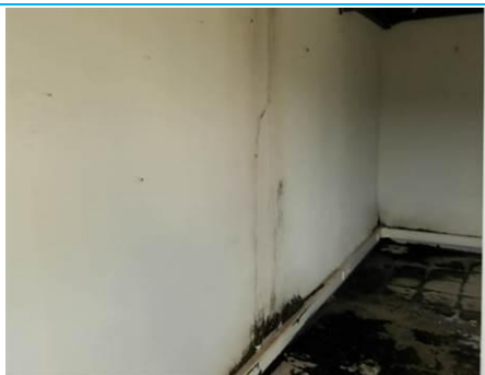
Matériaux : Z05 - Bureau - Mur - enduit + peinture Prélèvement : P007 Description : enduit + peinture Localisation : Bureau - Mur Résultat : Absence d'amiante
