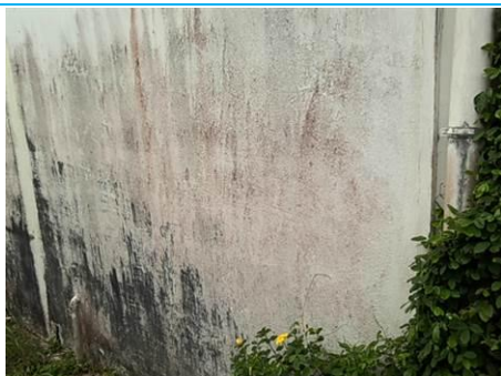
Matériaux : Z01 - Facades extérieures - Mur - Enduit + peinture Prélèvement : P003 Description : enduit + peinture Localisation : Parties extérieures - Facade Nord Résultat : Absence d'amiante
