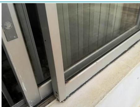
Matériaux : Z07 - Bureau - Joint de fenetre - Joint Prélèvement : P009 Description : joint de fenetre Localisation : Bureau - Fenetre Résultat : Absence d'amiante
