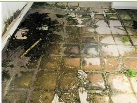
Matériaux : Z03 - Bureau - Sol 30X30 - colle de carreau Prélèvement : P005 Description : colle de carreau Localisation : Bureau - Sol Résultat : Absence d'amiante
