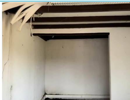
Matériaux : Z06 - Bureau - Poutre - enduit + peinture Prélèvement : P008 Description : enduit + peinture Localisation : Bureau - Poutre Résultat : Absence d'amiante
