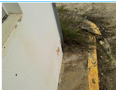
Matériaux : Z08 - Extérieure - Sol - chappe Prélèvement : P010 Description : chappe Localisation : Parties extérieures - Sol Résultat : Absence d'amiante
