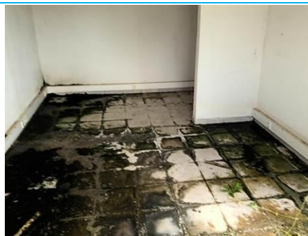
Matériaux : Z04 - Bureau - Plinthe 10x30 - colle de plinthe Prélèvement : P006 Description : colle de plinthe Localisation : Bureau - Plinthe Résultat : Absence d'amiante
