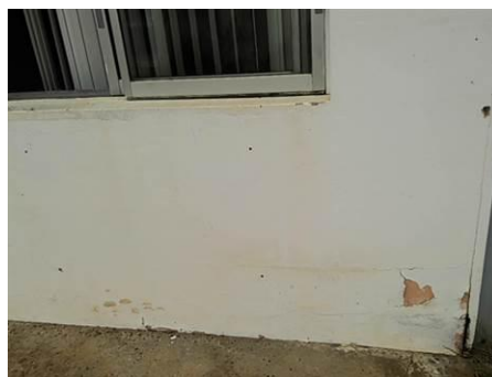
Matériaux : Z01 - Facades extérieures - Mur - Enduit + peinture Prélèvement : P002 Description : enduit + peinture Localisation : Parties extérieures - ouest Résultat : Absence d'amiante
