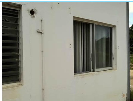
Matériaux : Z02 - Facades extérieures - Embrasure fenetre - enduit + peinture Prélèvement : P004 Description : enduit + peinture Localisation : Parties extérieures - Embrasure fenetre Résultat : Absence d'amiante
